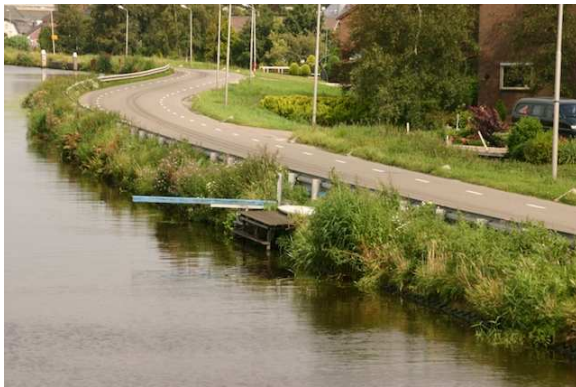
Foto 9: Springplank met steiger langs een openbare oever
